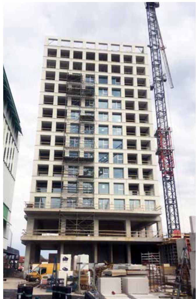
Elk individueel appartement is voorzien van een geothermische warmtepomp van NIBE, die via een thernet op de KWO is aangesloten.
